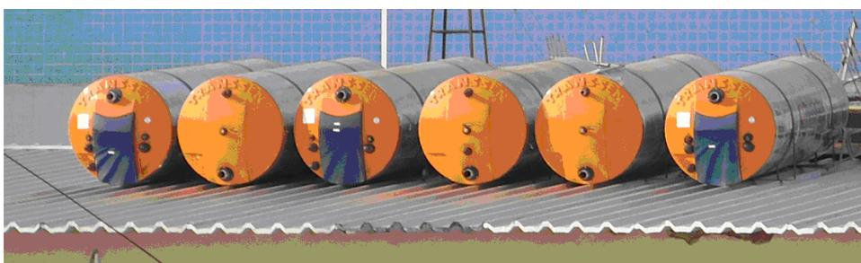
Figura 3 – Boilers do sistema de aquecedor solar.
