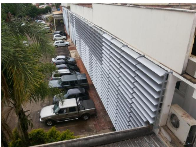
Figura 4 – Brise instalado na fachada
